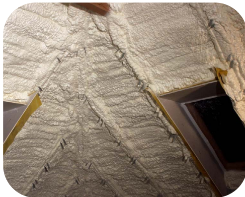
Dakisolatie met lycne H2foam gespoten isolatie
