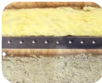
Links: Spouwmuur na bij-isoleren met enverifoam
